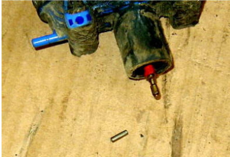
Hier das abgebaute Element mit der Spannhülse.
